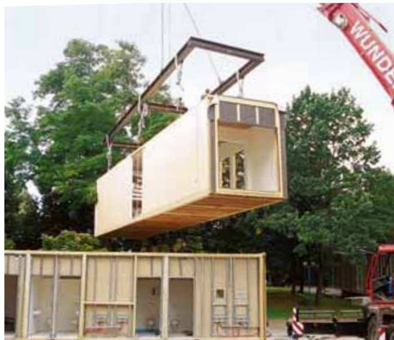
Der Schulpavillon des Augsburger Rudolf-Diesel-Gymnasiums wurde von der Gersthofer Schmid Holz- und Trockenbau GmbH in Modulbauweise errichtet. Foto: Schmid
