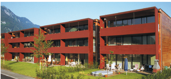
Reihenhäuseranlage „Bieleweg“, Ludesch
