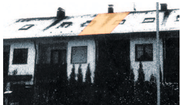
Abb. 9: Über einen laufenden Meter Wärmebrücke am Mauerwerkskopf geht genauso viel Wärme verloren wie über drei Quadratmeter ungestörte Dachfläche. Schwächen im Dachbereich lassen sich bei Schneelage wie in diesem Bild sehr einfach auch optisch erkennen am abgetauten Schnee
