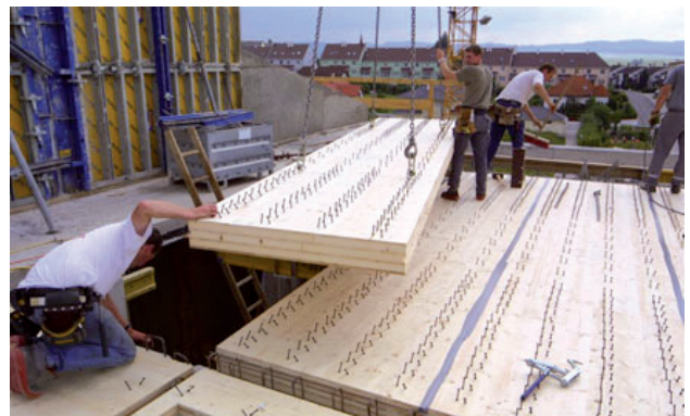
Montage von Elementen mit Schraubverbindern auf der Baustelle ( www.ancon.at )
