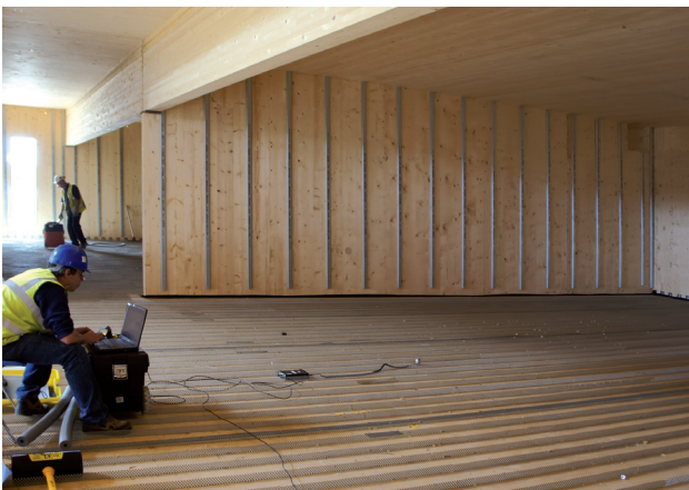
Vorbereitung von KLH® HBV-Elementen für die Einbringung des Aufbetons auf der Baustelle (TimCrete © Ramboll)
