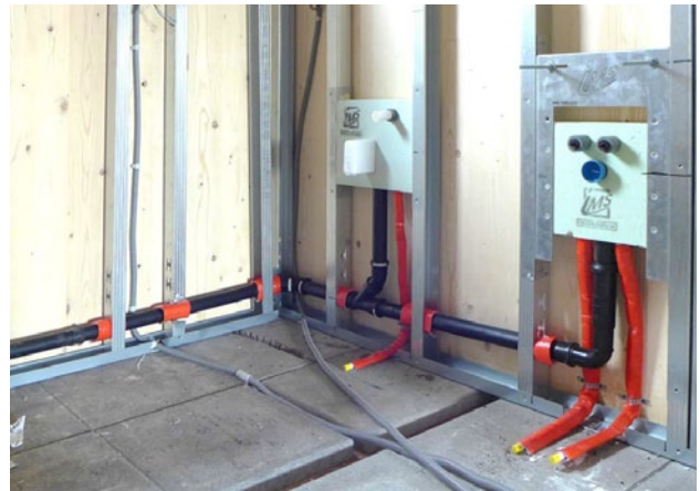
Abb. 65 - Installationsführung in der Vorsatzschale
