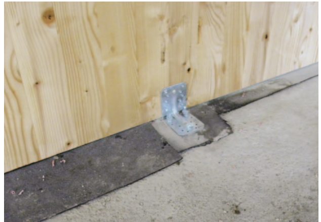
Abb. 38 - Feuchtigkeitsabdichtung
