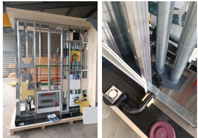
Abb. 67 - Mockup einer Systemlösung mit Abdichtungswanne
