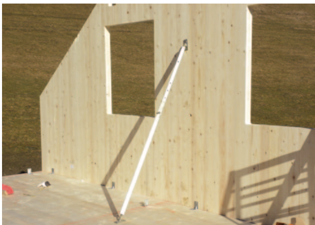
Abb. 43 bis 46 – Montage der KLH®-Elemente
