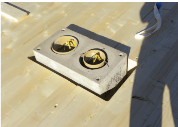
Abb. 47 - Montage Fertigteilkamin
