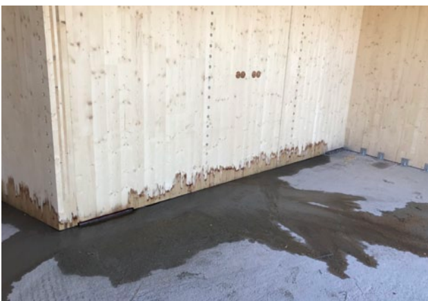
Regenwasseraufnahme am ungeschützten Hirnholz
