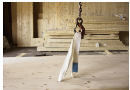
3. Hebesituation mit eingebautem System FD
