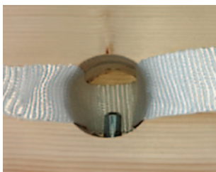
1. Schleife und Bolzen in Bohrung einsetzen
