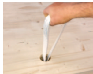
2. Hebesituation mit eingebautem System VLS S
