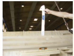
4. Hebesituation mit eingebautem System FB
