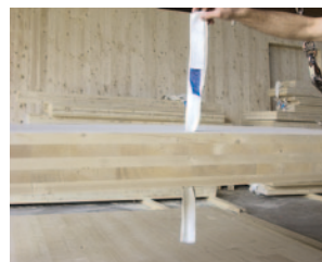
1. Schlaufe in Bohrung einsetzen
