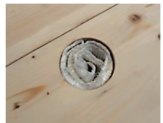
3. Transportsituation mit eingearbeiteter Schleife im Bohrloch
