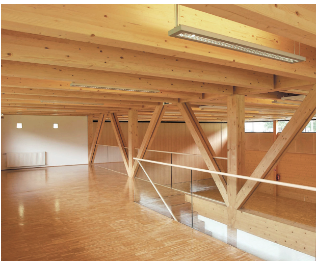
Einsatz von KLH-Rippenelementen bei einer Veranstaltungshalle
