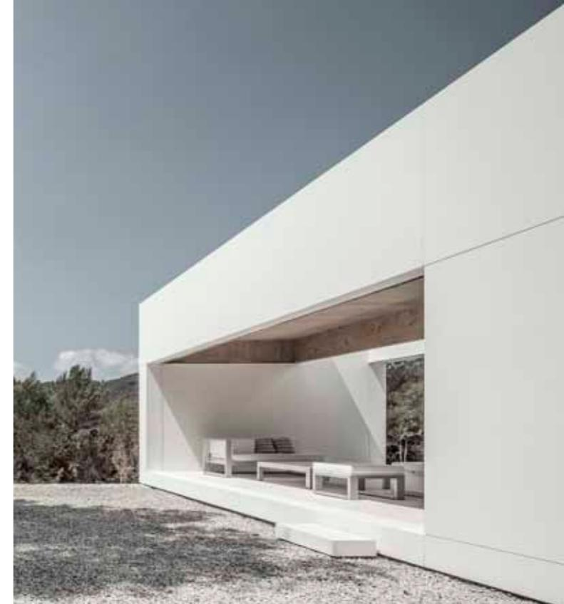
Alle Böden innen sowie die Abdeckungen der Feuchtbereiche, der Pool und die begehbaren Terrassen sind aus natürlichem Kalkstein in verschiedenen Formaten und Oberflächen ausgeführt. Das Schichtholz der äußeren Hülle weist dieselben Eigenschaften auf wie das Brettsperrholz-Tragwerk, wodurch die Grenzen zwischen der Gebäudehülle und den Holzbauteilen verschwimmen und die Materialien besser miteinander harmonieren.
