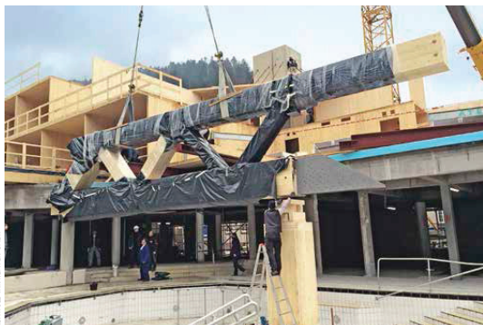
ABBRUCH VAN EEMEN/OMN
