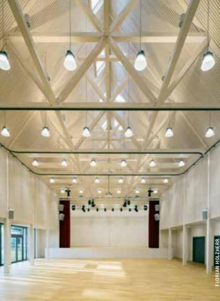
Über dem Bürgersaal bilden sechs BSH-Binder das Tragwerk des Satteldachs. Sie formen zusammen mit den Diagonalen eine besondere Konstruktion
