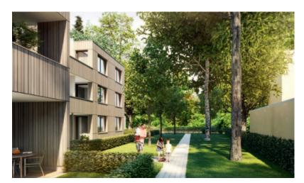
◆ Eine vertikal angeordnete Fassadenlattung teilt die Fassadenflächen durch horizontale Fugen an den Fensteroberund -unterkanten in sieben horizontal verlaufende Bänder ein
