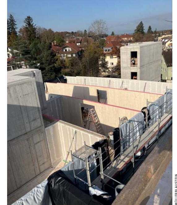
▲ Aufbau auf der Baustelle
