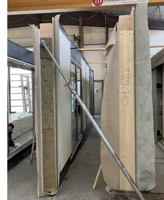
▲ Montage Außenwände im Werk
