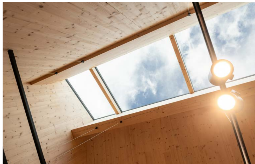
▲ Das Lichtband gewährleistet eine gleichmäßige, natürliche Belichtung bis tief in den Raum
