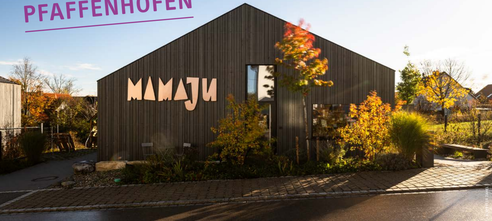
▲ Die Wandbauteile wurden in Stärken von 100 und 120 mm ausgeführt, die Dachkonstruktion mit 100 und 140 mm starken Massivholzplatten
