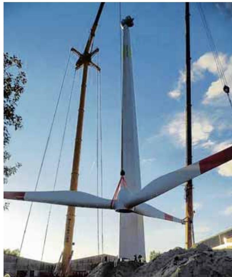
Ein Windrad und eine stählerne Generator-turbine trägt inzwischen der 100 Meter hohe Holzturm aus Bobingen. Fotos: ABA Holz
