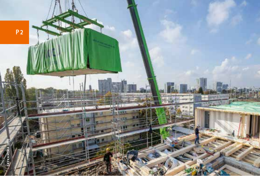
◀ Das Setzen der Module auf dem bereits montierten Ringanker nahm pro Haus etwa zwei Wochen in Anspruch
