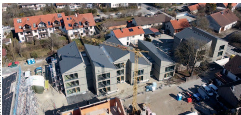
KOMMUNALUNTERNEHMEN UTTING AM AMMERSEE
