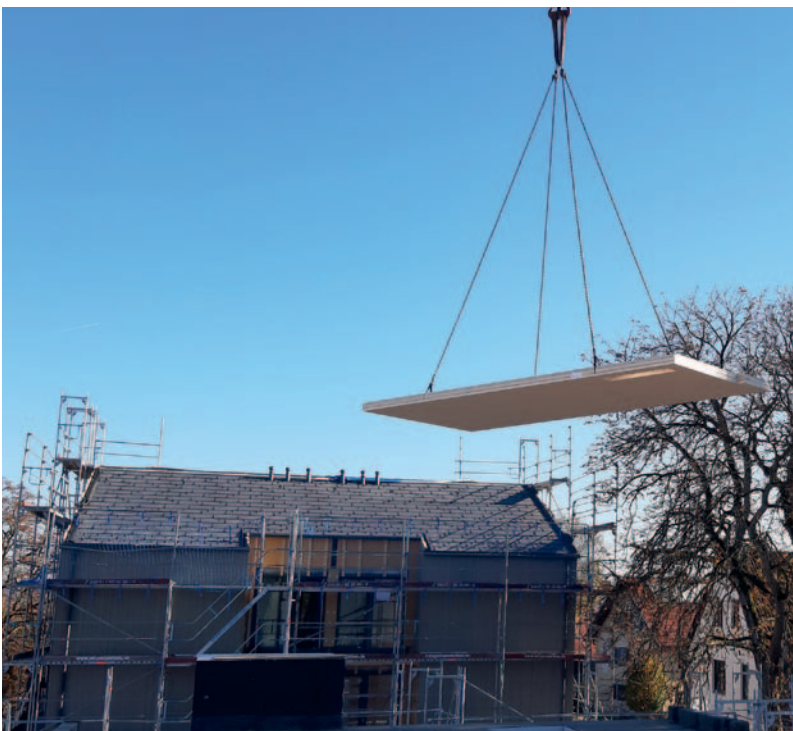
◀ Die Decke wird mit dem Kran an den gewünschten Platz gehoben
